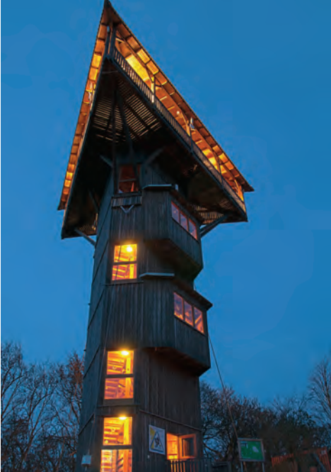
Der Holzbau ist 22,5 Meter hoch.
