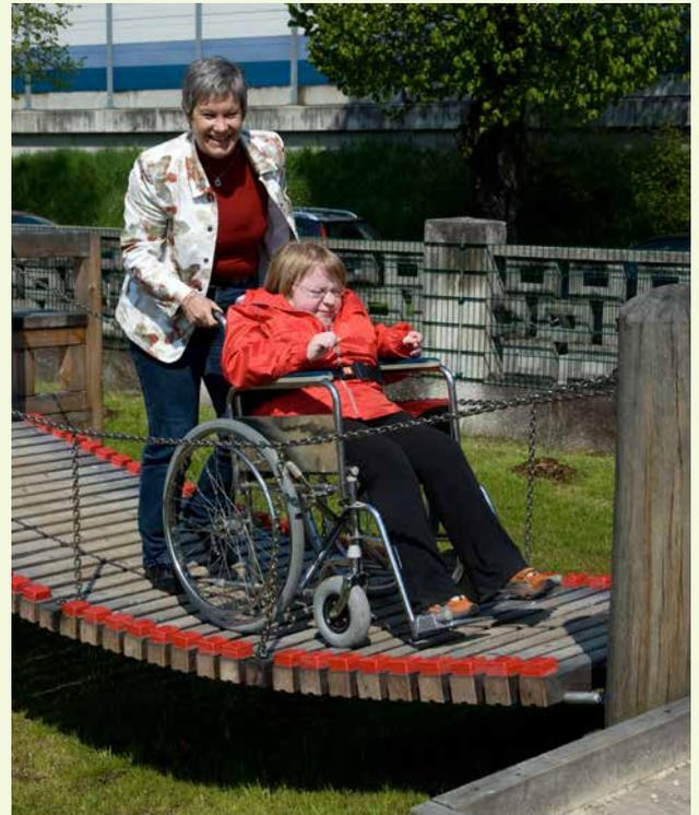
*Mittels Aufrüstung (Radabweiser), enger gesetzten Laufbrettern und durch straffere Spannung ist diese Hängebrücke auch für Rollstuhlfahrer/-innen bespielbar/befahrbar*
