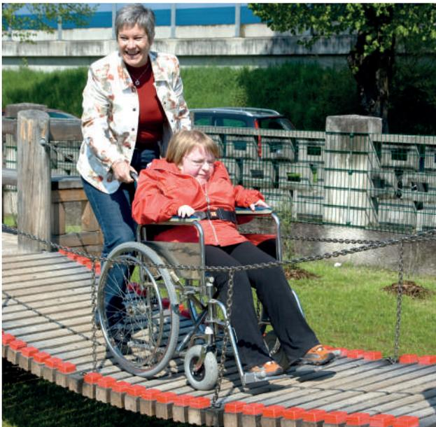
Durch Radabweiser, enger gesetzte Laufbretter und straffere Spannung ist diese Hängebrücke auch für Rollstuhlfahrerinnen und Rollstuhlfahrer bespiel- und befahrbar.
